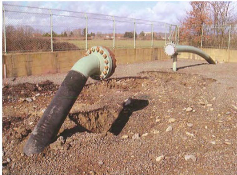
Figure 3 : Vue du site de l'ancienne gare racleur d'Arance après démantèlement
